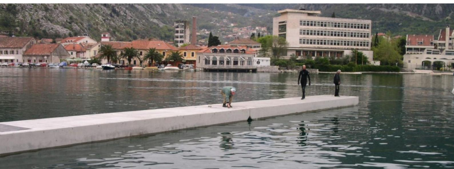
Površina HD pontona može biti prekrivena drvenom palubom/decking do visine nadvođa od 1 m.
