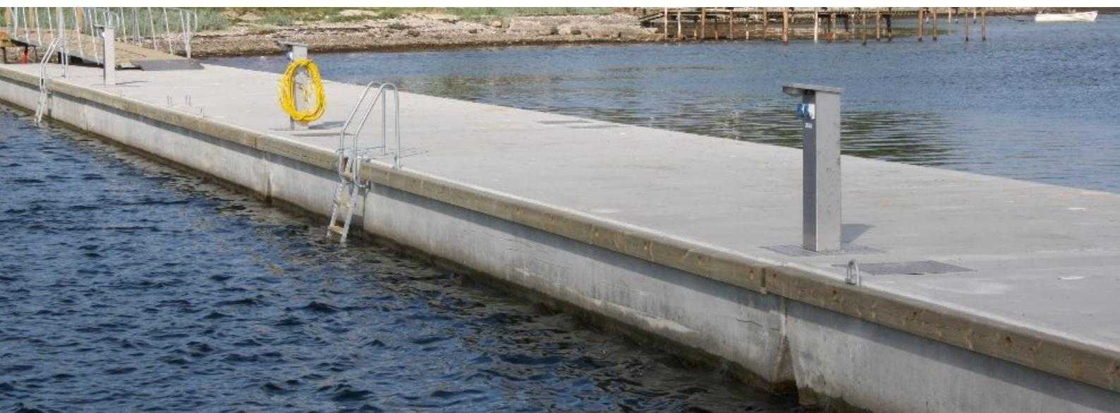
Površina HDW valobranskog pontona može biti prekrivena drvenom palubom/decking do visine nadvodja od 1m.
